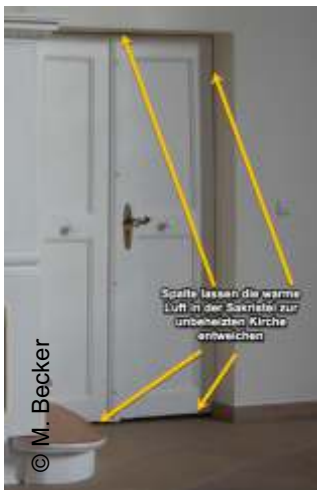
die Sakristeitür vor und nach der Abdichtung von Spalten
