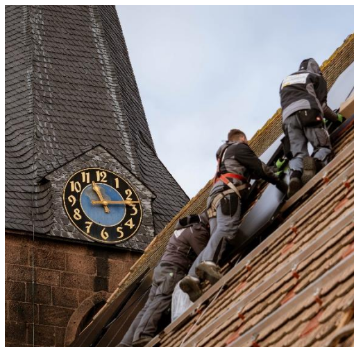
Neue Prioritäten der Landesdenkmalpflege ermöglichen eine PV-Anlage auf dem Dach der Kirche in Rhodt
