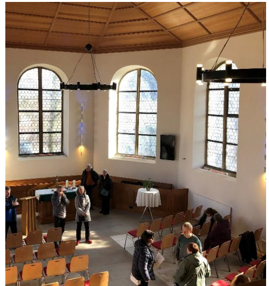
Infrarot-Deckenstrahler und andere Heizelemente schaffen Behaglichkeit bei geringem Verbrauch.
