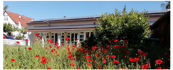
Gemeindehaus mit Photovoltaik-Anlage
