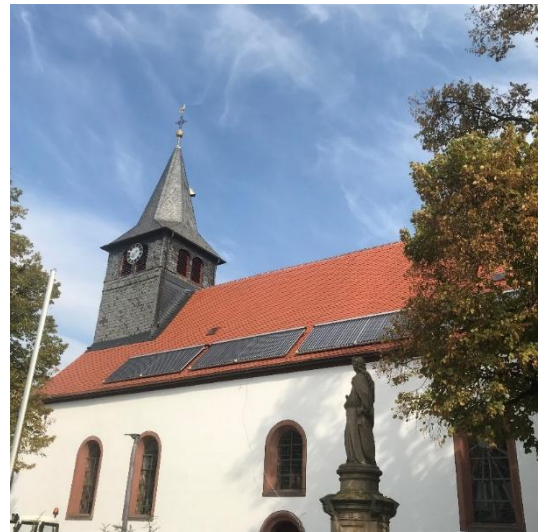
Solarthermie auf dem Kirchendach
