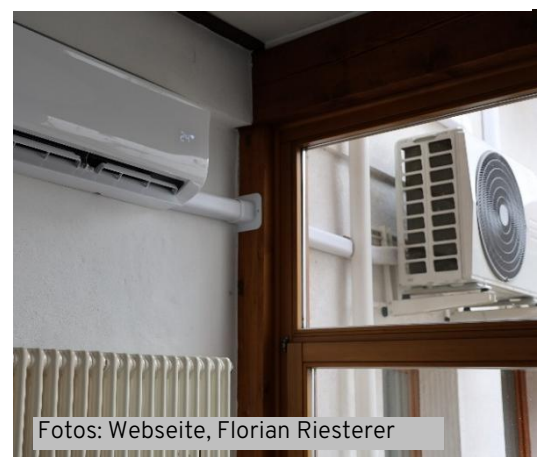
Heizung lässt sich von Ferne steuern Luft-Luft-Wärmepumpe mit Innen- und Außengerät
