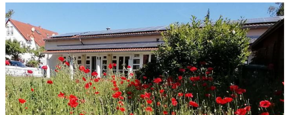
Gemeindehaus mit Photovoltaik-Anlage
