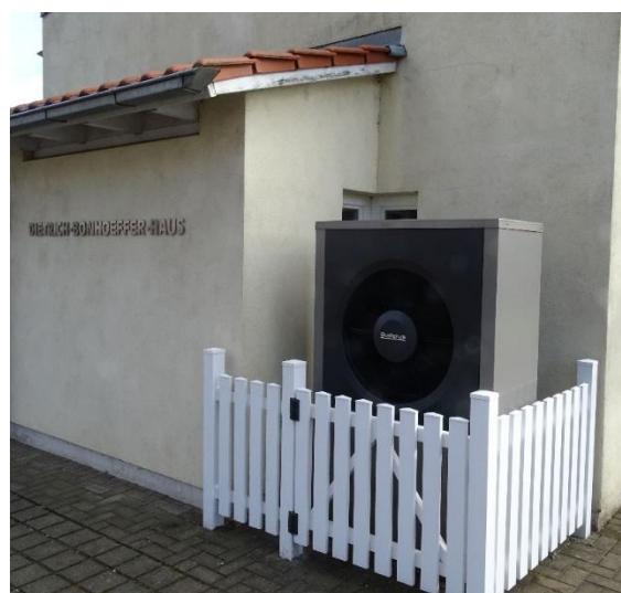
Außengerät und Innengerät der Wärmepumpe
