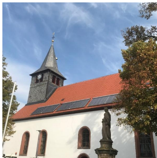
Solarthermie auf dem Kirchendach
