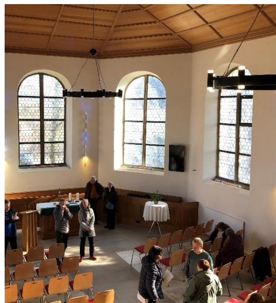
Infrarot-Deckenstrahler und andere Heizelemente schaffen Behaglichkeit bei geringem Verbrauch.
