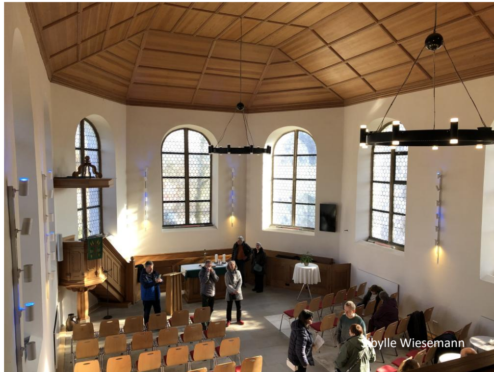
Zwei große Deckenstrahler mit Infrarot und integrierter Beleuchtung
