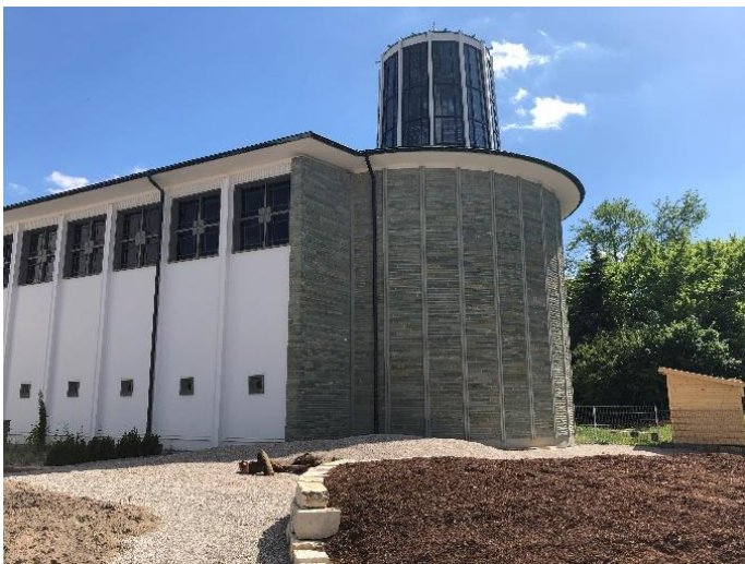
Spätsommer 2025: Garten entsteht
